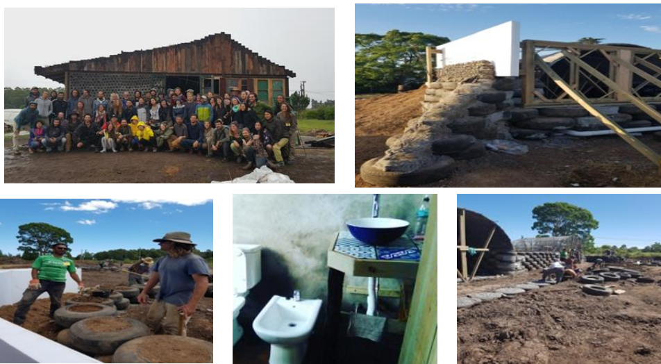
تصویر ۱: مجتمع ساکرامنتو (Earthshipbiitecture, 2019)
